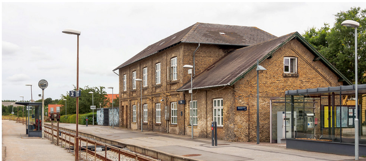
Vrå station set fra sporsiden, retning mod nord.
